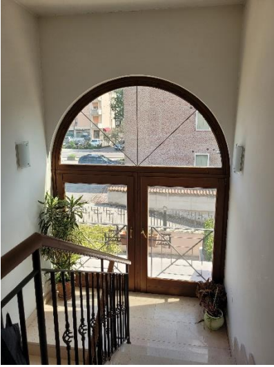
VANO SCALA E TERRAZZO (NON ACCESSIBILE)
