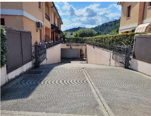
RAMPA ACCESSO AUTORIMESSE
