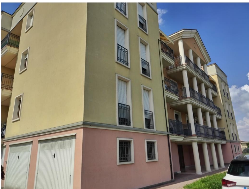
Figura 16. Foto immobili Vista esterna – Prospetto Sud/Ovest
