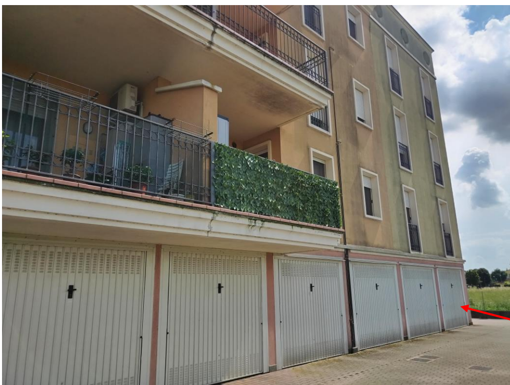
Figura 18. Foto immobili Vista esterna – Prospetto Nord/Autorimessa
