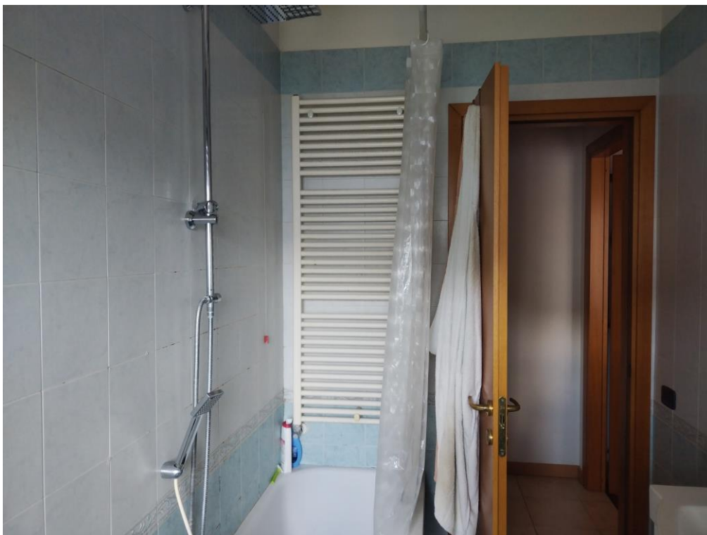
Figura 10. Foto immobili Vista interna – Bagno
