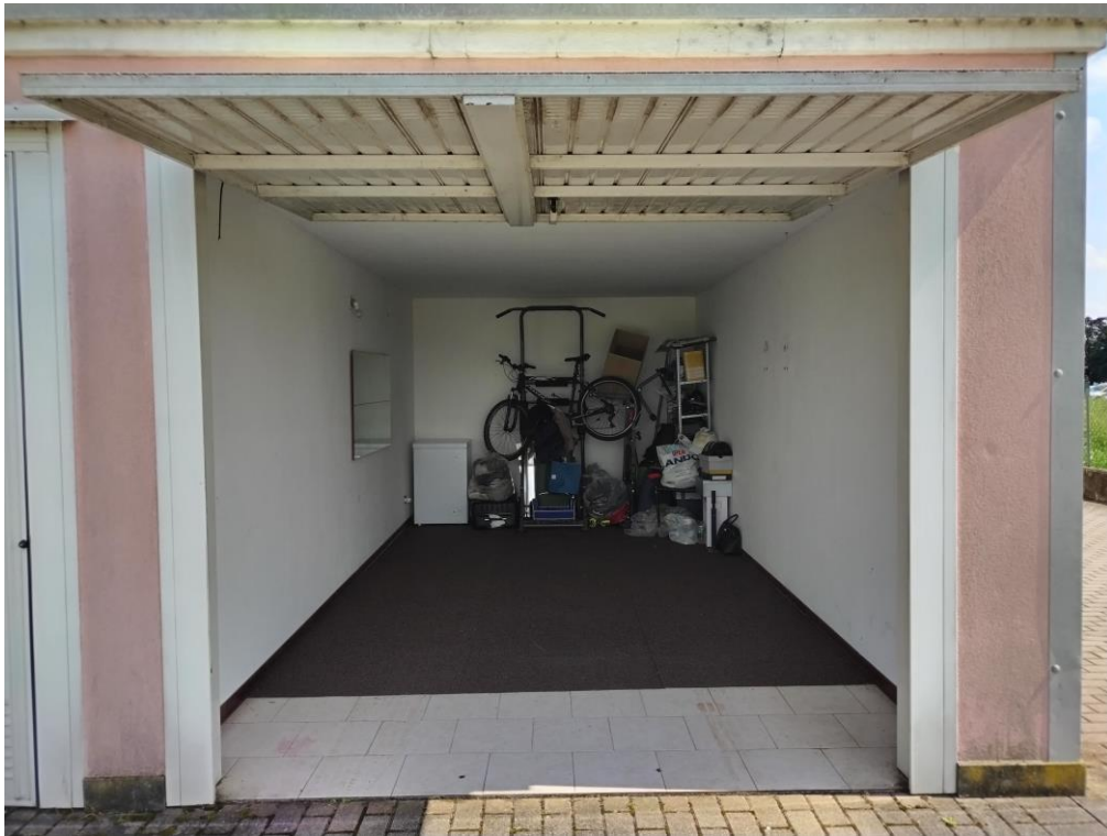
Figura 19. Foto immobili Vista interna – Autorimessa
