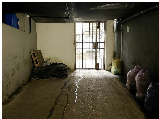
Vista dell'ex passaggio carrabile di accesso all'autorimessa
