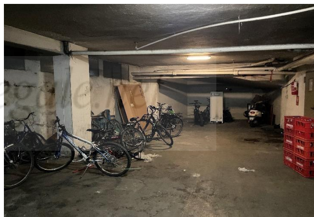
Vista della corsia dell'autorimessa interrata
