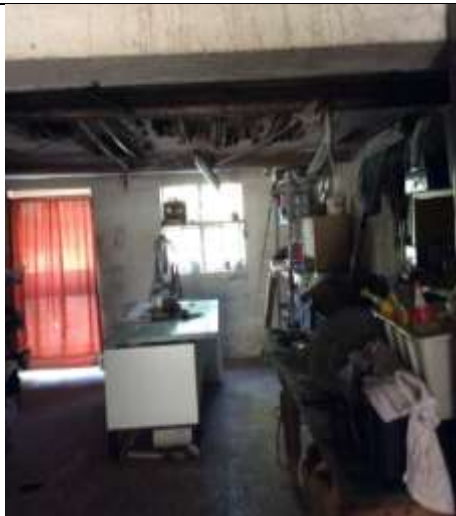
Foto 7: PT – sub 6 Garage
