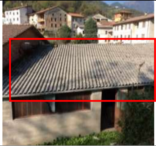
Foto 16: Copertura in eternit (riquadro rosso) sopra deposito sub 5
