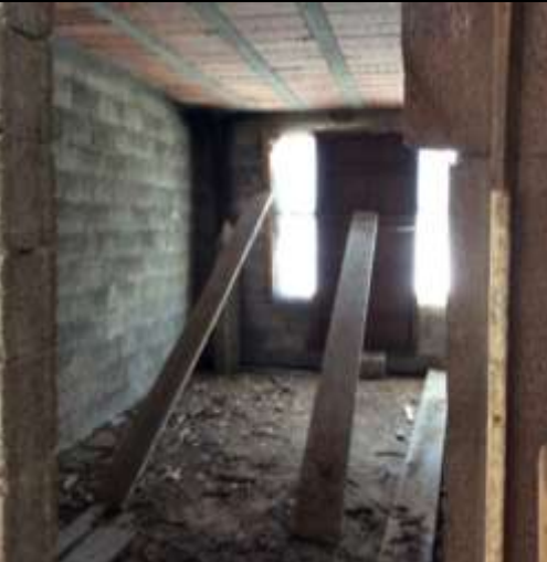
Foto 13: P1 – sub 5 Deposito
