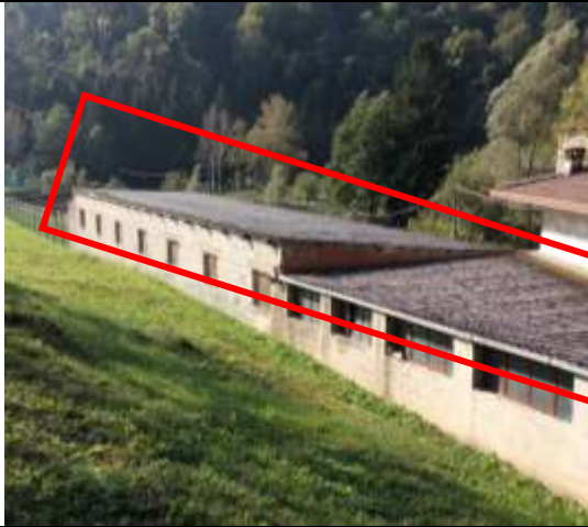
Foto 15: Copertura in eternit (riquadro rosso) sopra magazzini sub 5
