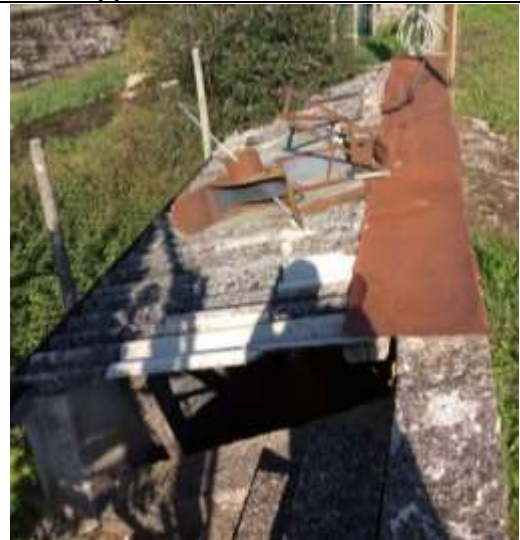
Foto 20: Centralina idroelettrica con copertura in amianto su mappale n. 451
