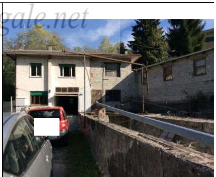
Foto 2: Edificio di cui al m.n. 231 Fabbricato abitazione/magazzino/depositi
