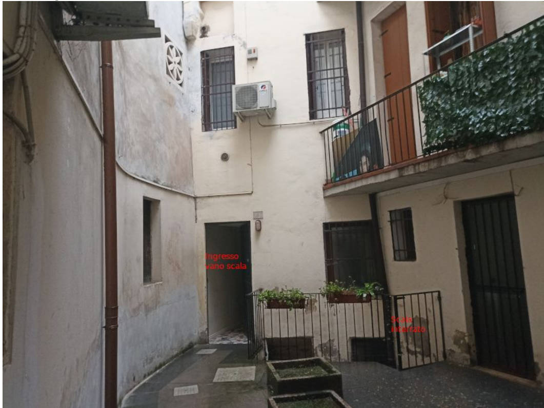
Fotografia 3 – ingresso vano scala da cavedio interno
