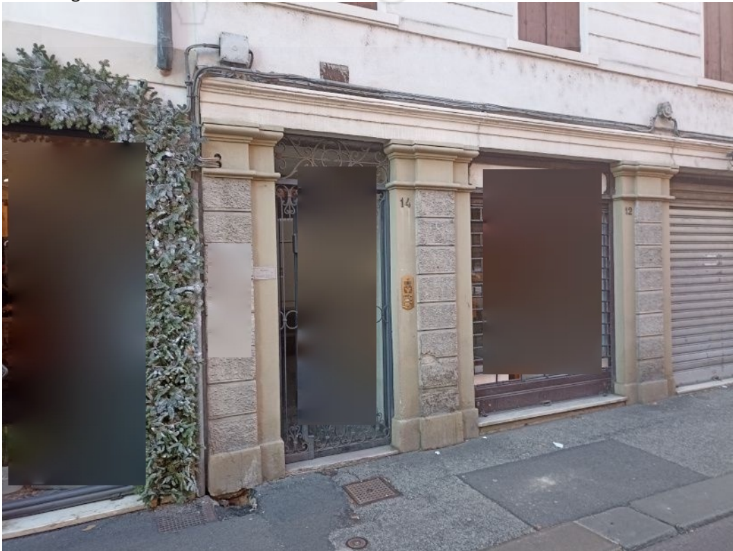
Fotografia 2 – Ingresso condominiale da Contrà Ponte San Paolo
