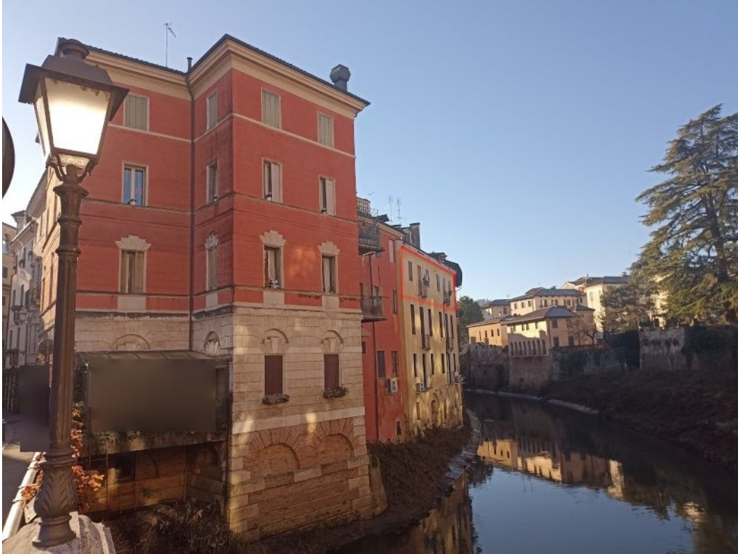
Fotografia 1 – dal ponte di Contrà Ponte San Paolo
