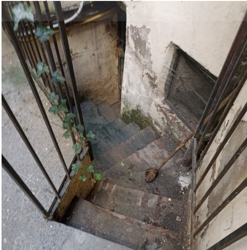
Fotografia 10 – scala interrato (vedi indicazione foto 3)
