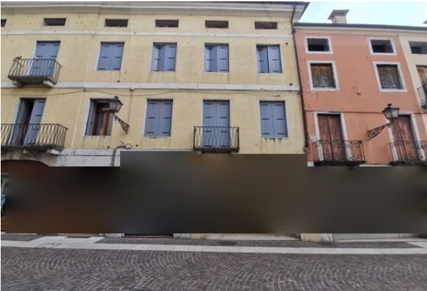
Vista fronte ovest fabbricato da Corso Italia
