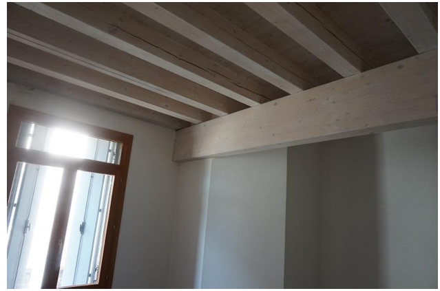
Piano primo – Particolare soffitto camera
