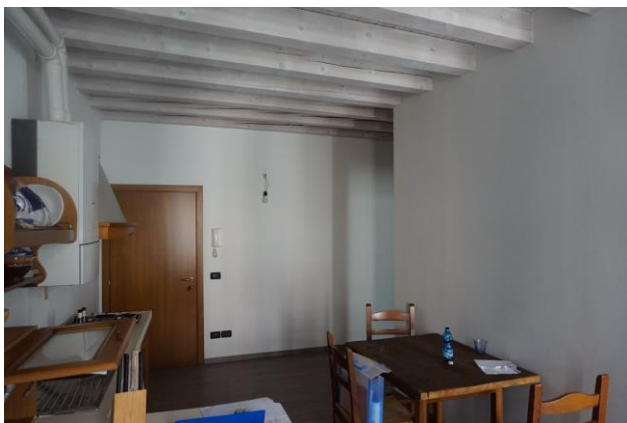
Piano primo – zona ingresso da cucina soggiorno
