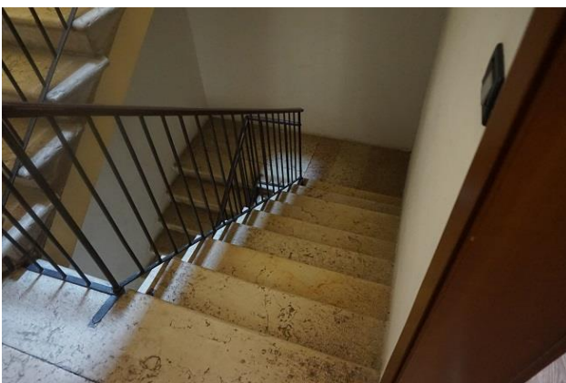
Piano primo - Particolare scala comune
