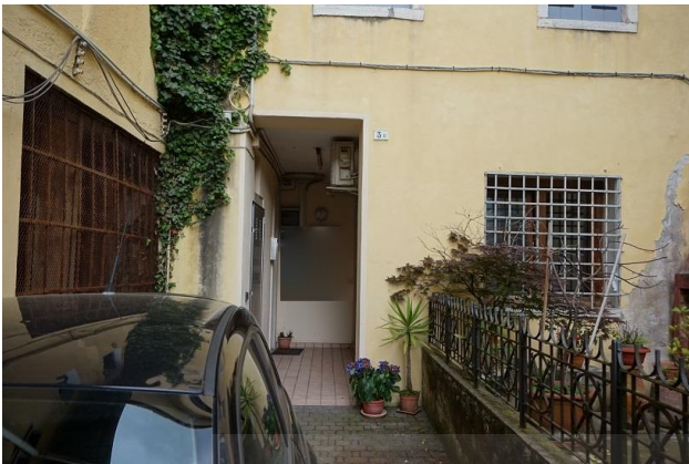
Particolare ingresso est fabbricato da corte interna
