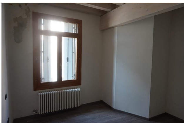
Piano primo – Camera lato nord/ovest
