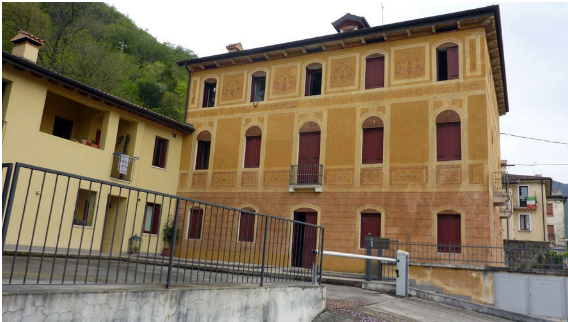
Vista intero edificio fronte sud-est
