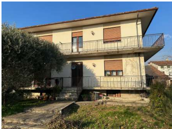
Vista dalla strada (lato sud).
