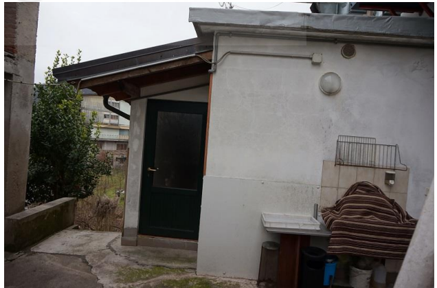
Fronte nord da area esterna ad est
