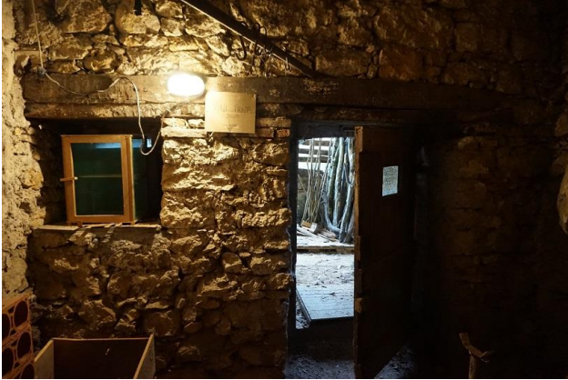
Vista ingresso da nord verso sud
