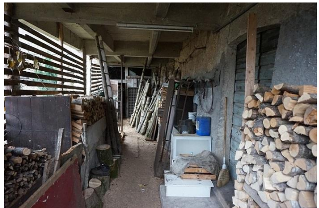
Zona porticata comune a sud piano interrato (da est)
