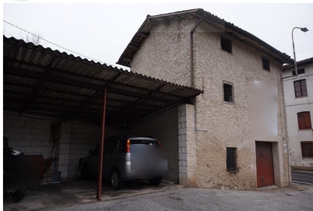
Fronte sud da area manovra (Particella n.1143)
