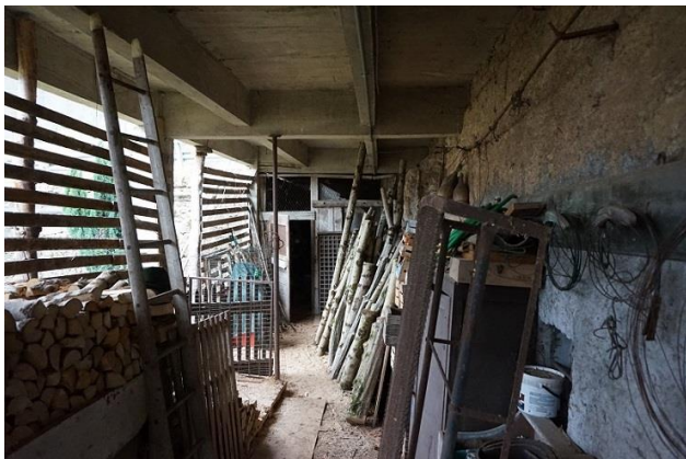
Zona porticata comune a sud piano interrato (da est)
