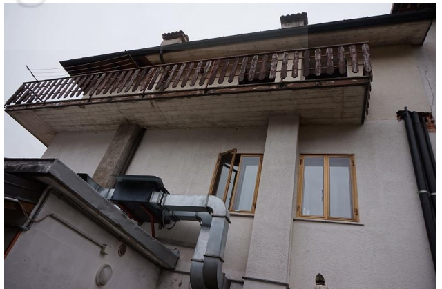
Fronte est da corte interna
