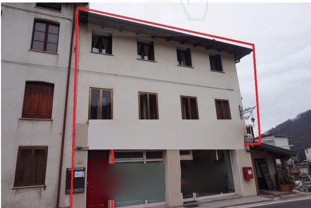
Fronte ovest con evidenziata unità abitativa
