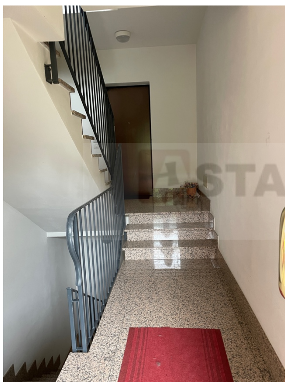
Figura 6. Vano scale condominiale.
