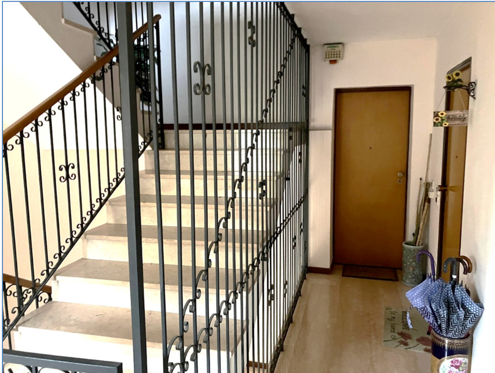
Foto 3 : Ingresso da vano scala
