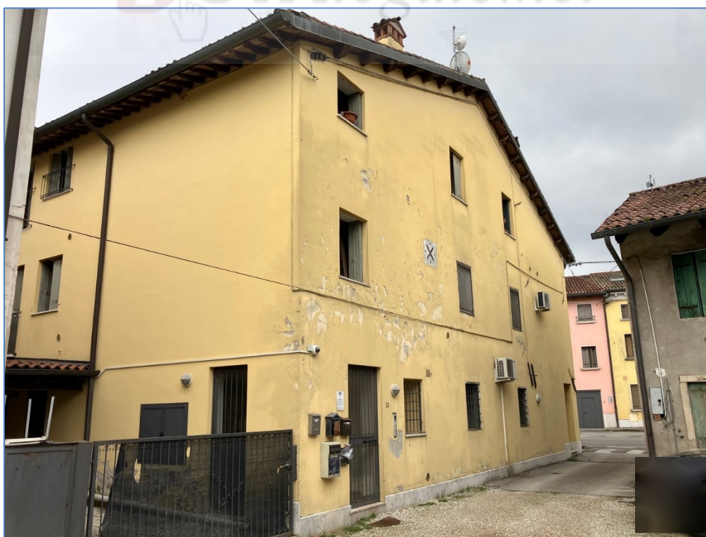
Foto 2 : Particolare ingresso dalla corte
