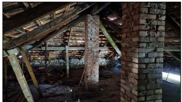
Copertura e colonne in muratura centrali
