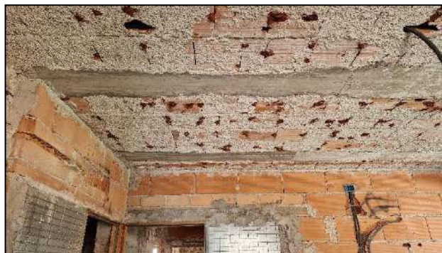
Intradosso dell'ultimo solaio piano
