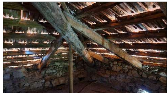
Trave cantonale di displuvio della copertura
