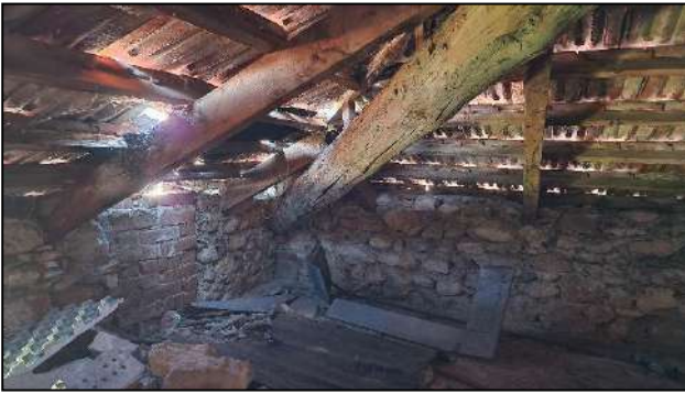
Trave cantonale di displuvio della copertura
