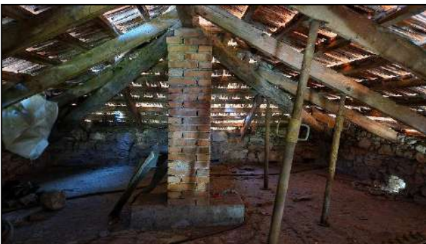
Copertura e colonna in muratura lato est
