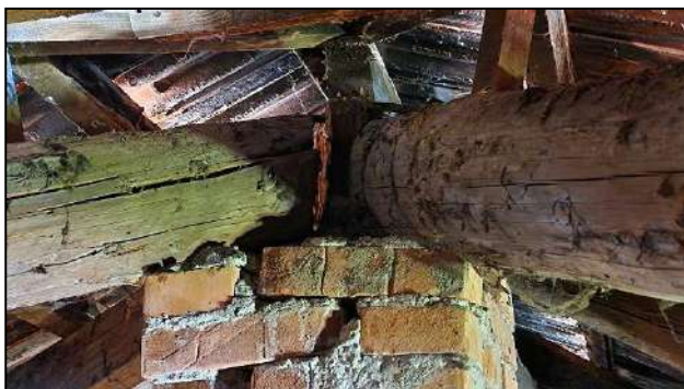
Carenze strutturali/costruttive delle connessioni lignee
