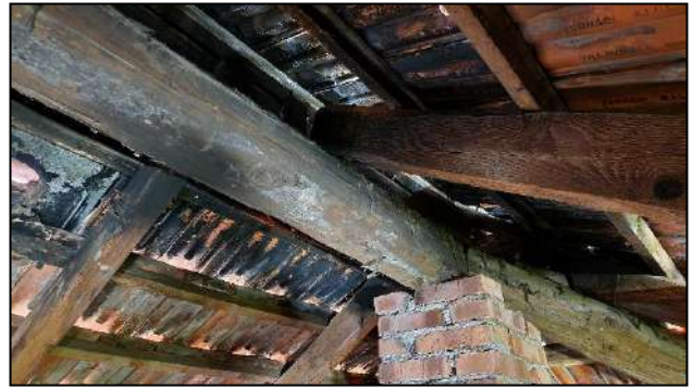
Trave di colmo di copertura
