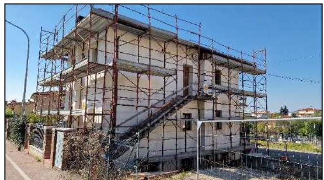
Fronte nord dell'edificio
