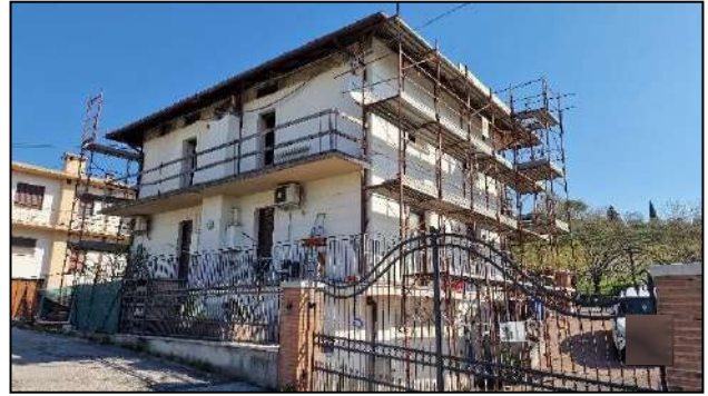
Fronti ovest e sud dell'edificio
