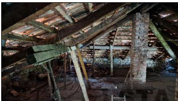
Puntelli rompitratta della copertura
