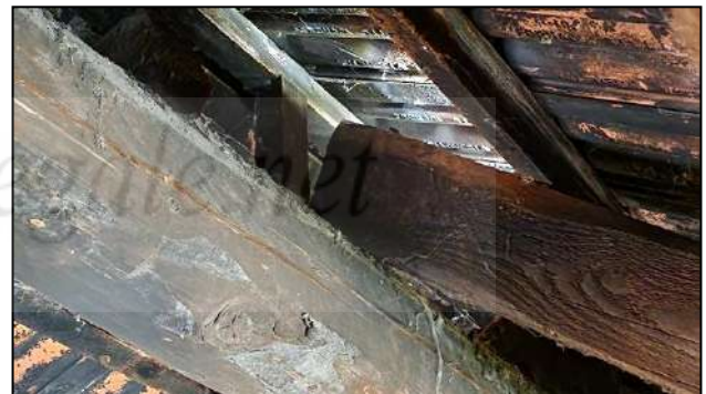
Appoggio di arcareccio su trave di colmo
