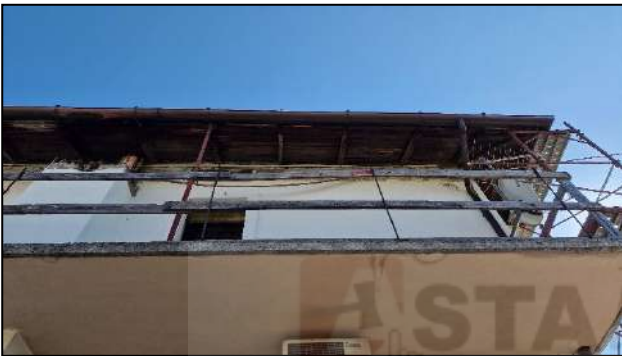
Cornicione di copertura in legno
