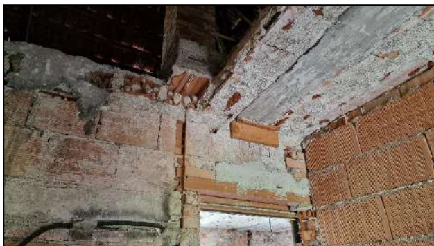
Ultimo solaio piano in latero-cemento
