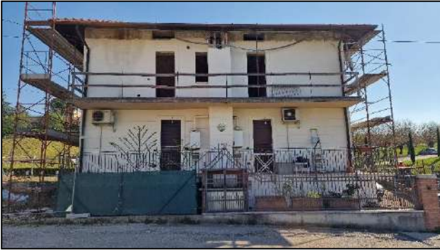
Fronte ovest dell'edificio
