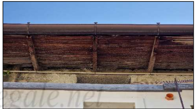
Dettaglio del cornicione
