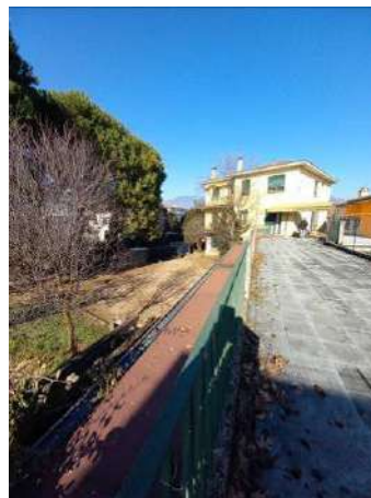
VISTA TERRAZZA COP. GARAGE
