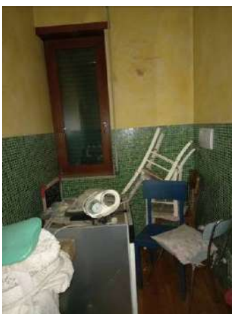
VISTA BAGNO 1P
