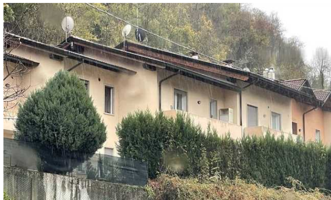
Vista del fabbricato da Nord Ovest
