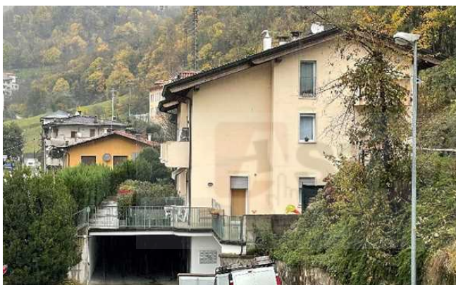
Vista del fabbricato da Sud
