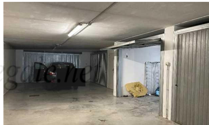
Vista della corsia dell'autorimessa interrata
