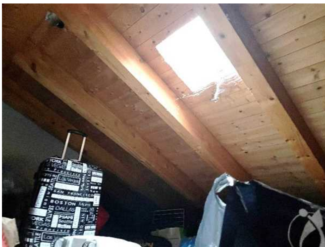
Vista del sottotetto
