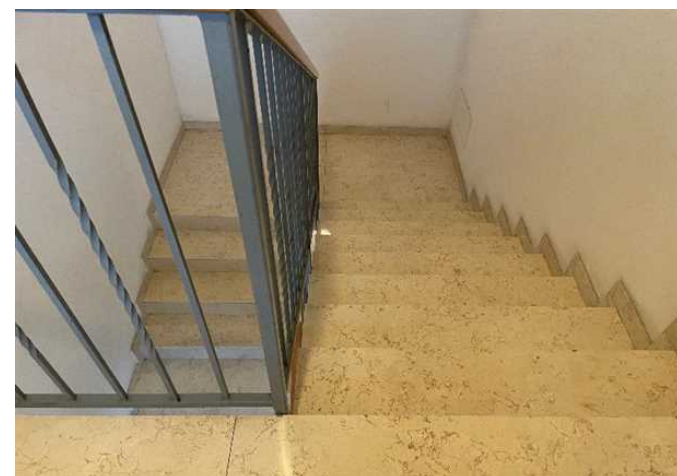
Vista della scala comune
