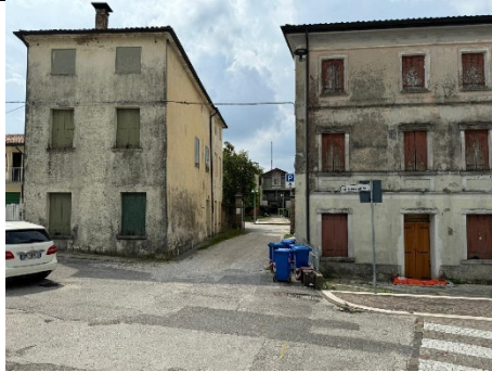
Foto 1. VISTA ESTERNA (panoramica)
