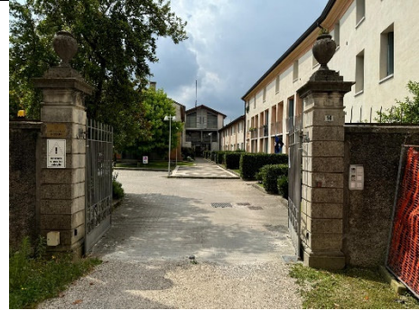
Foto 2. VISTA ESTERNA (panoramica)
