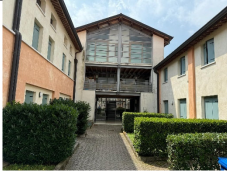
Foto 3. VISTA ESTERNA (ingresso com.)
