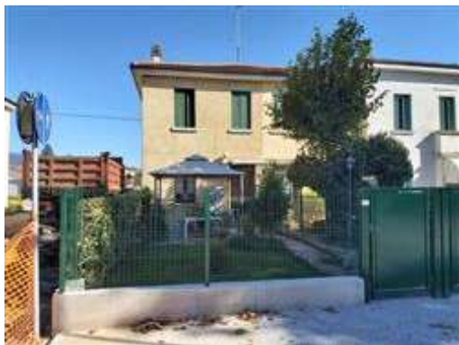
Vista esterna da via Marconi
