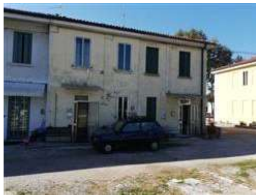
Vista esterna - retro
