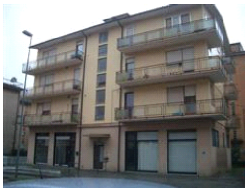
Vista generale da Nord-Est
