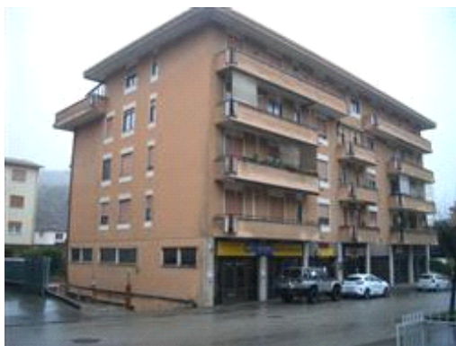
Vista generale da Nord-Ovest
