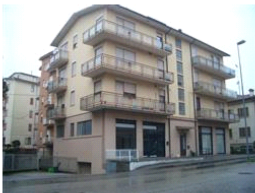
Vista generale da Sud-Est
