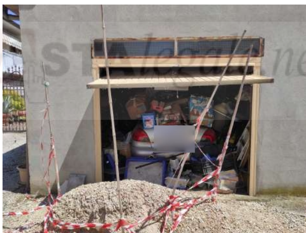
Figura 18 accesso al sub.2
