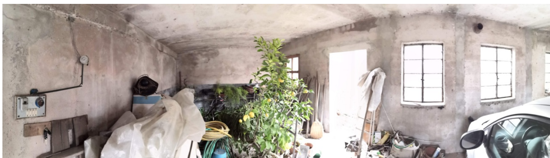
Figura 7. Foto interne autorimessa.
