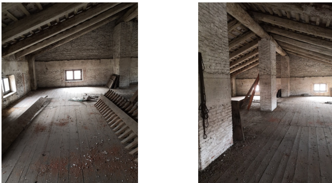
Figura 5. Foto interne deposito.
