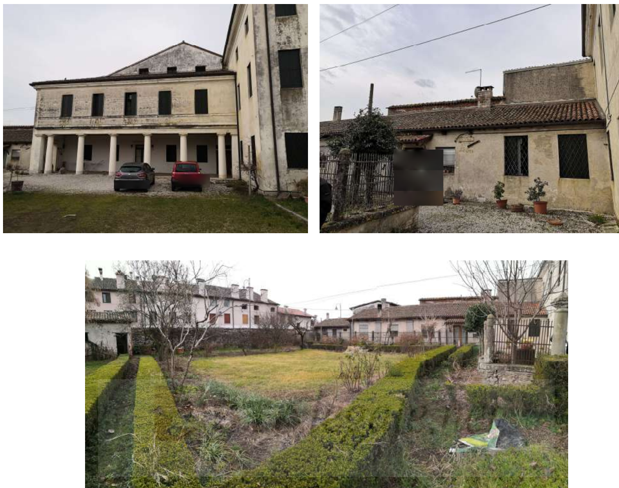
Figura 3. Foto esterne immobile.
