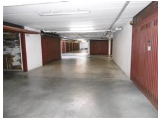
Corsie di accesso al garage (parti comuni)
