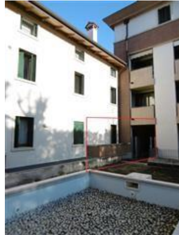
Prospetto interno con individuazione dell'immobile oggetto di perizia – lato sud
