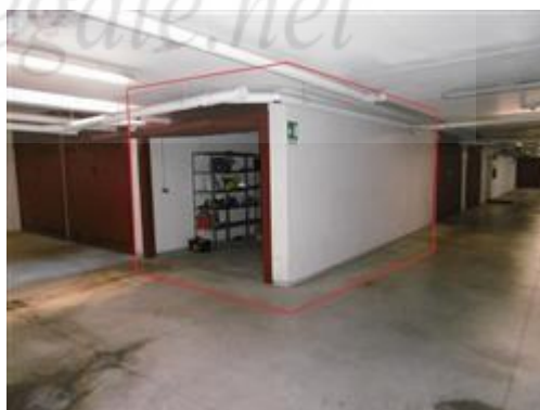
Garage di pertinenza
