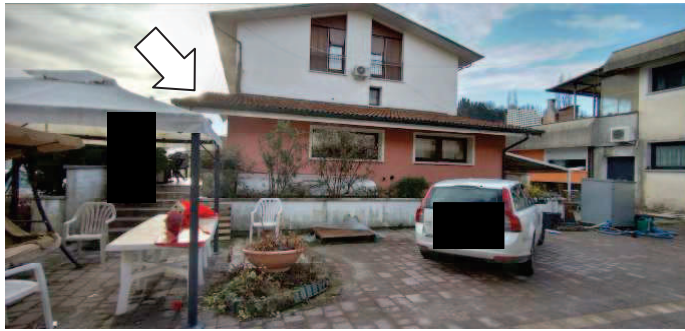
Vista dell'edificio e posizione dell'ingresso dell'immobile
