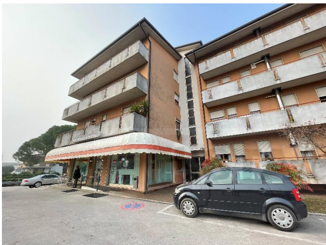
Vista del fabbricato condominiale dalla Via S. Maria
