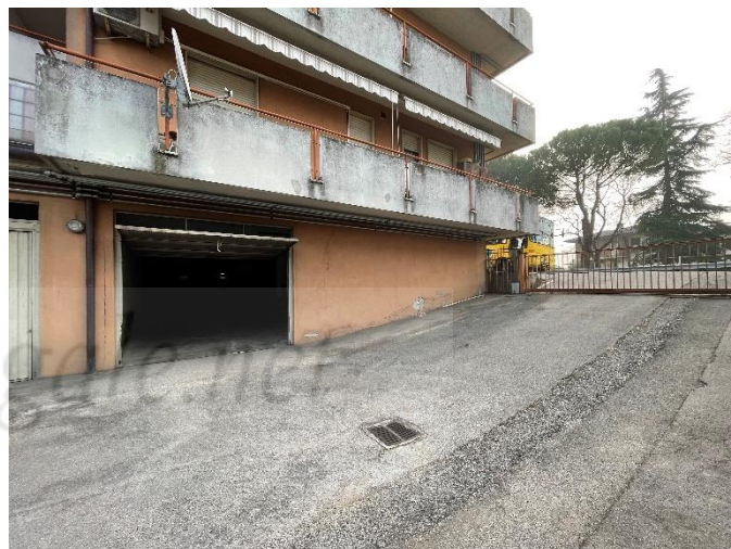
Vista del fabbricato da Ovest sull'accesso carraio
