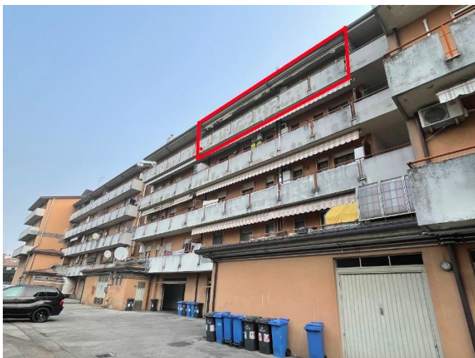
Vista del fabbricato condominiale da Ovest
