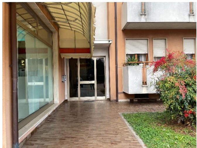
Vista dell'ingresso comune alla scala "C" del condominio
