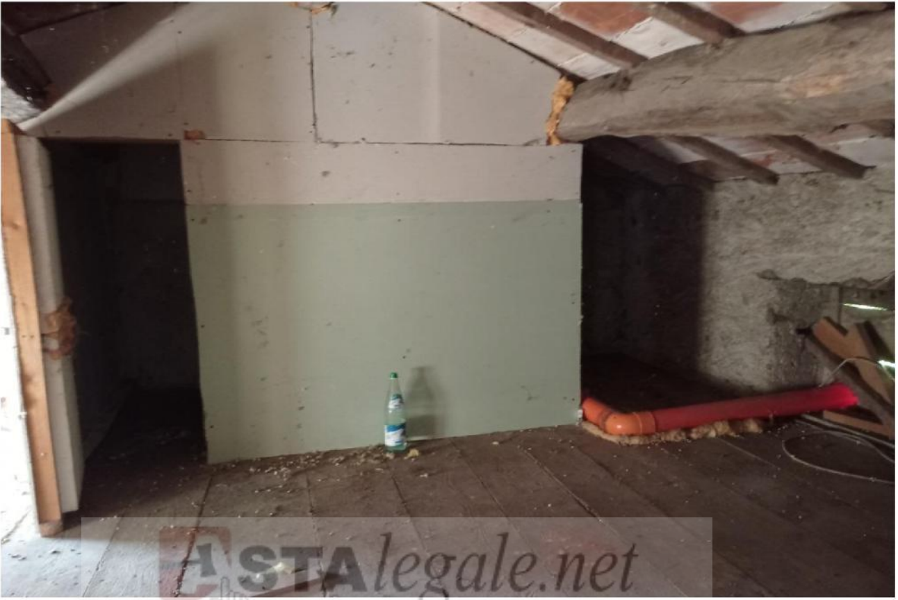
Figura 6 – LOCALE PIANO TERZO
