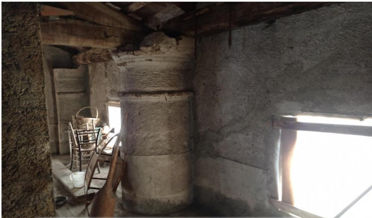
Foto 4: LOCALE PIANO TERZO
