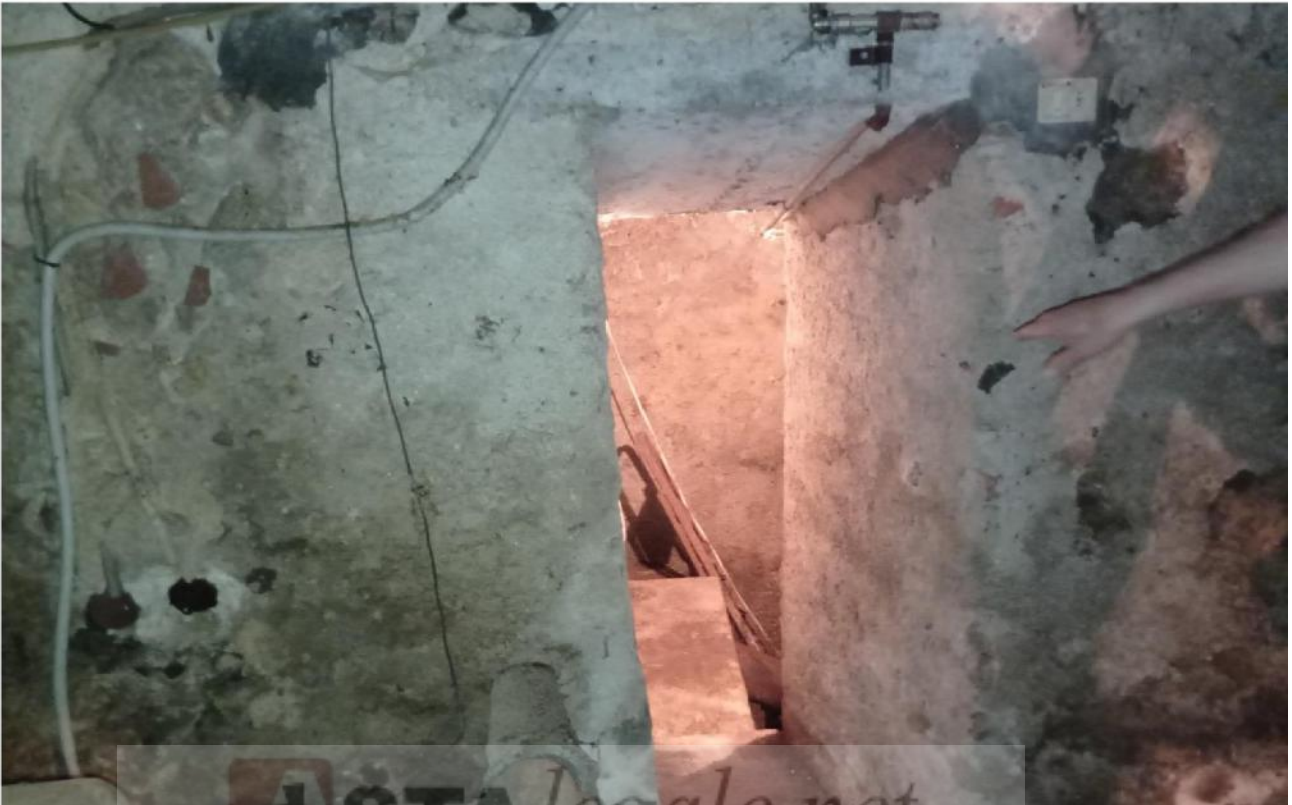
Foto 6: LOCALE PIANO INTERRATO
