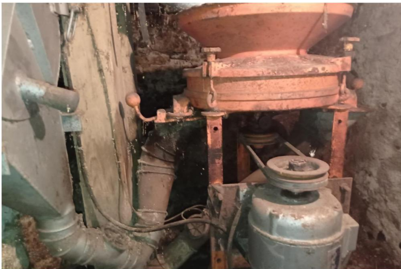
Foto 3: LOCALE PIANO INTERRATO
