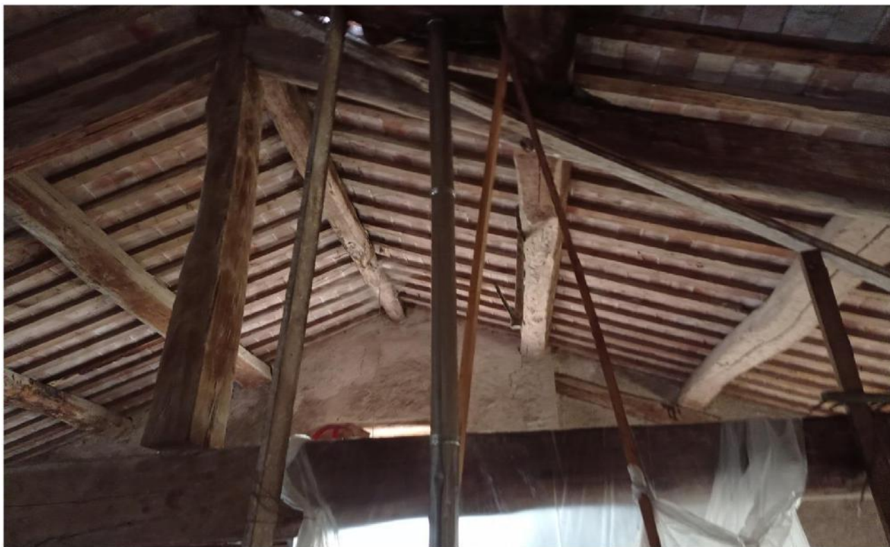
Foto 1 – LOCALE PIANO TERZO
