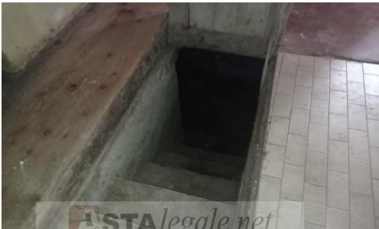
Foto 2: ACCESSO LOCALI PIANO INTERRATO
