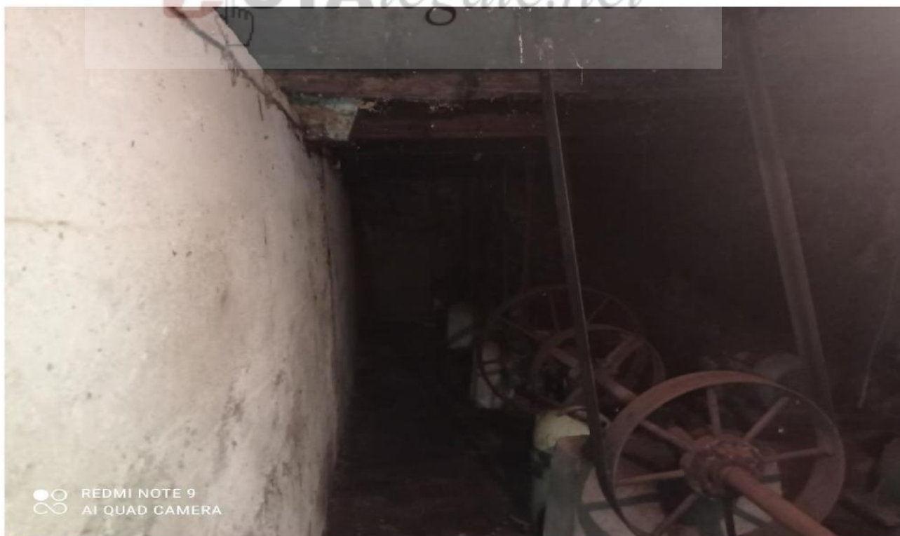
Foto 5: LOCALE PIANO INTERRATO
