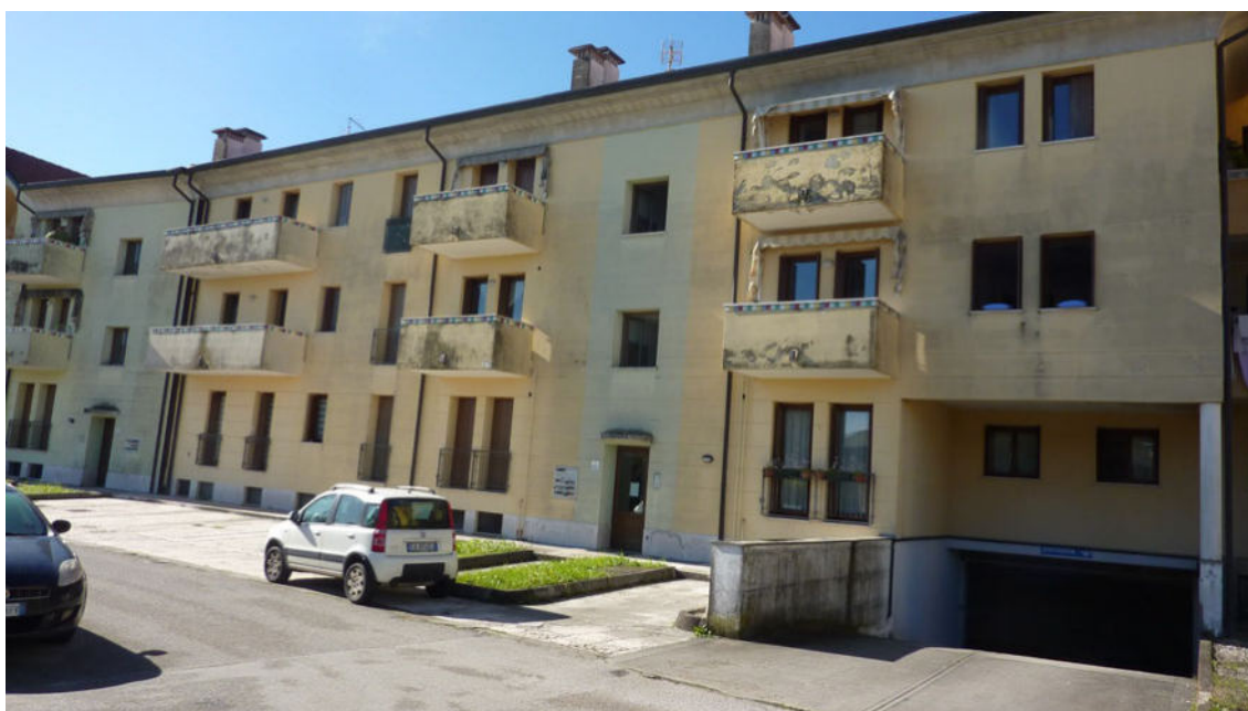
Vista intero edificio fronte nord-est
