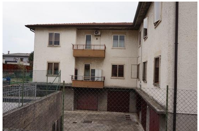
Vista da ovest verso est con corsia piano seminterrato
