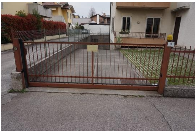
Ingresso carraio dalla pubblica via a sud
