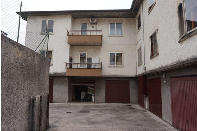
Fronte ovest con accesso garage da corsia comune
