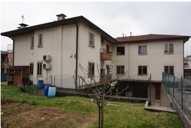
Vista da corte interna (da nord/ovest)
