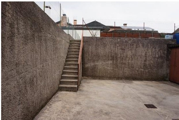
Scala collegamento tra corte a nord e corsia di manovra
