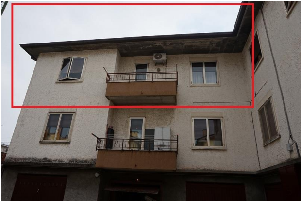
Fronte ovest con evidenziata unità abitativa
