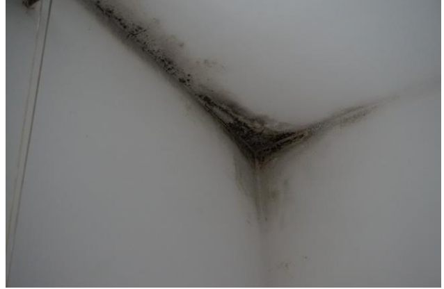
Piano primo – Particolare soffitto camera a nord
