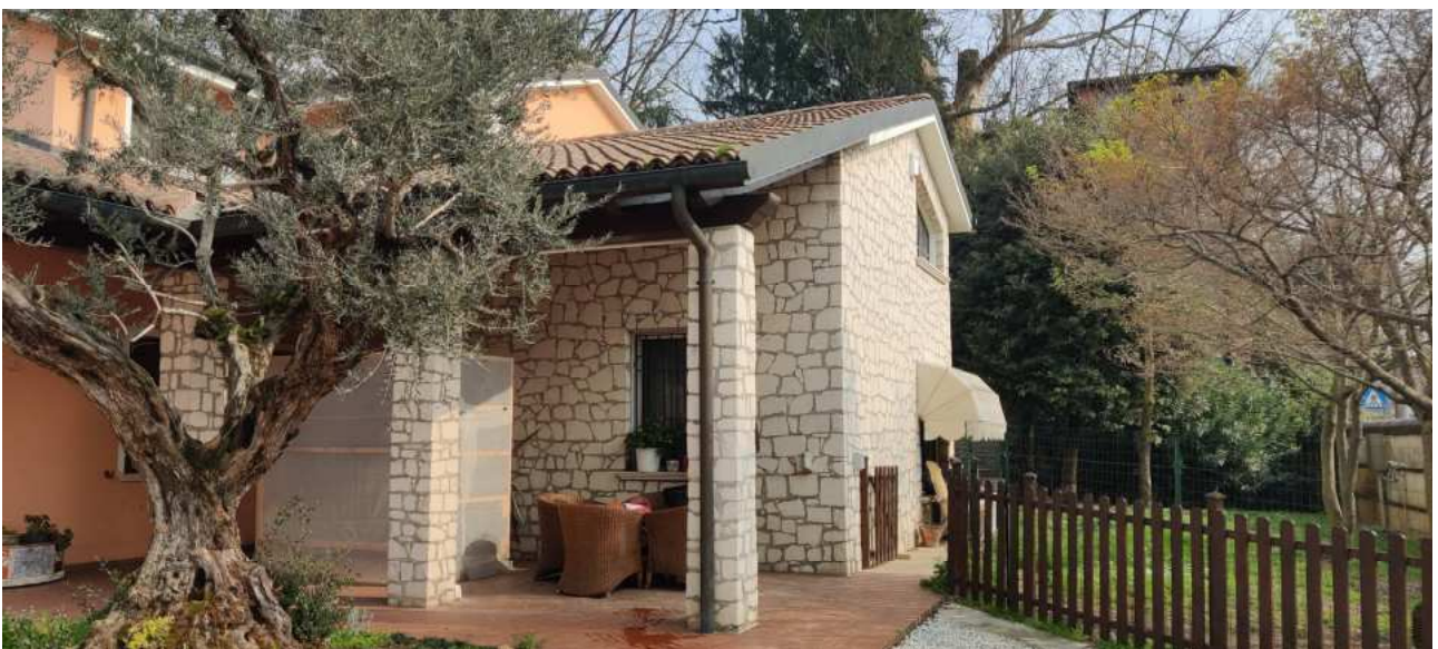
Vista dal cortile interno
