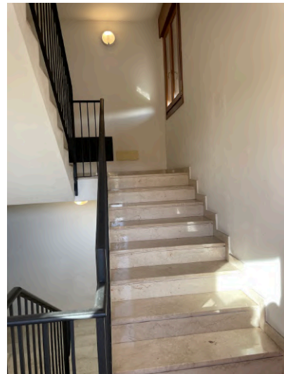
Foto 3. Vano scala comune
