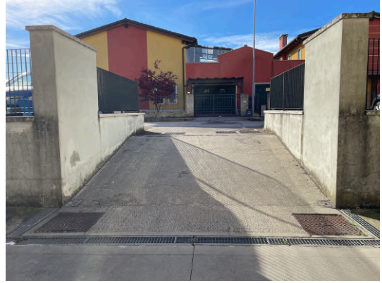
Foto 19. Rampa di accesso al piano seminterrato
