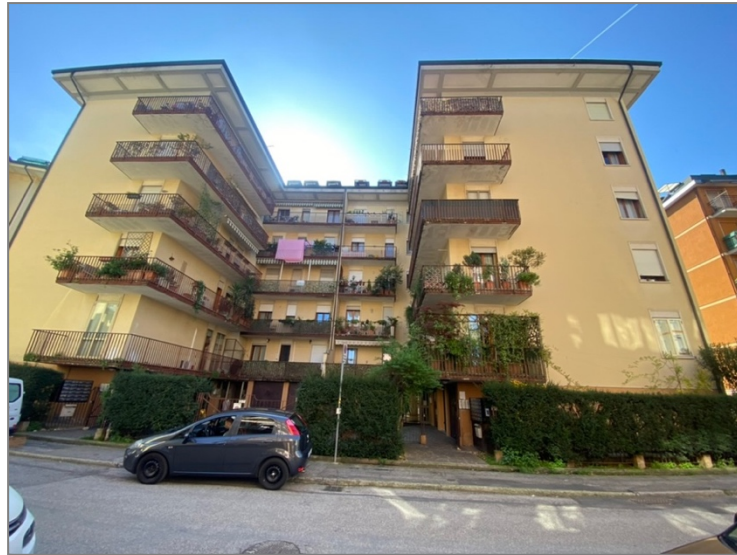
Fronte principale e ingresso condominiale
