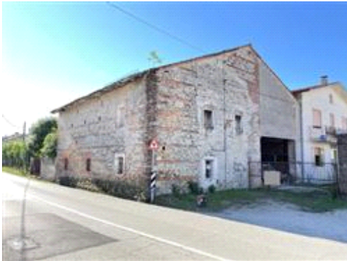
Vista da Via Santa Romana sull'accesso carraio.
