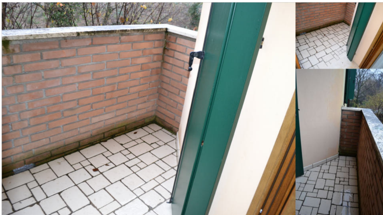
Fig.73-74-75-1° PIANO - TERRAZZA DI PERTINENZA DELLA CAMERA MATRIMONIALE
