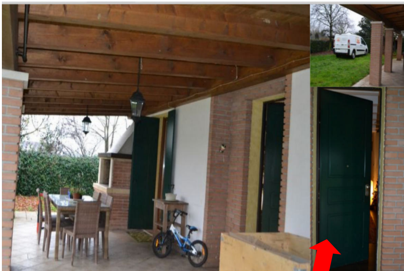
Fig.18-INGRESSO PRINCIPALE DAL PORTICO
