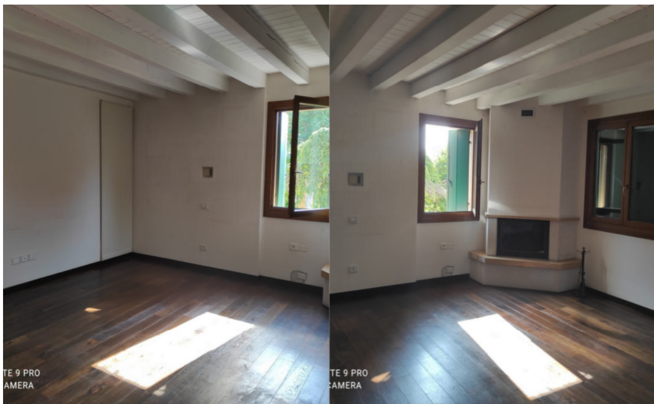
Fig.28-29- ZONA GIORNO PIANO TERRA INGRESSO -SOGGIORNO CON CAMINO;
