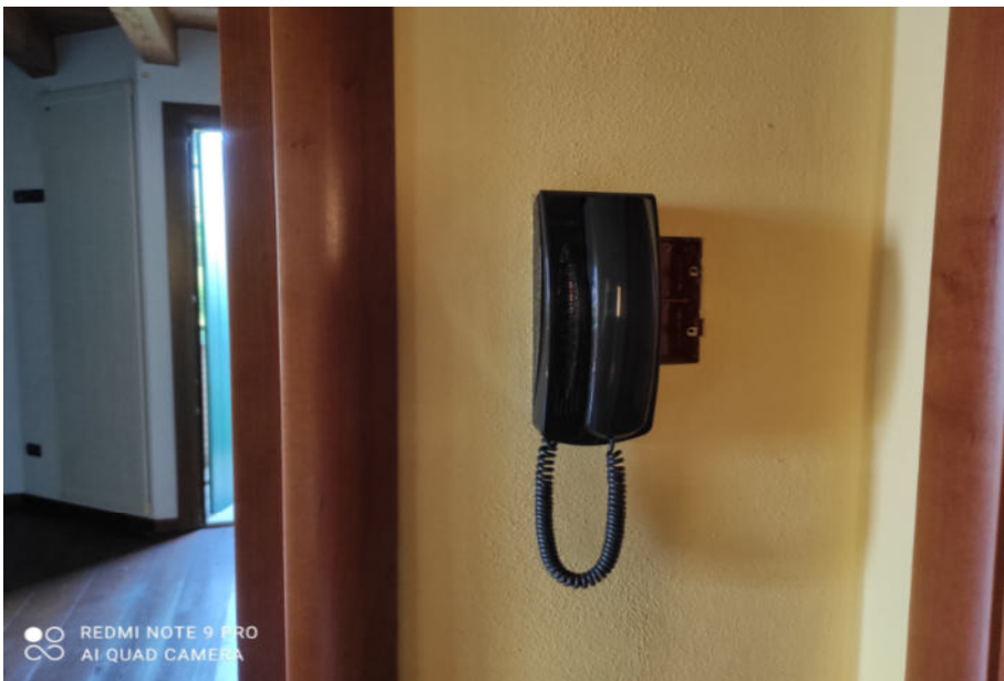
Figure 83-84-85- PIANO TERRA- STATO IMPIANTI IN CUCINA DURANTE SOPRALLIOGO DEL 13 DICEMBRE 2022- STATO IMPIANTI IN CUCINA DOPO ASPORTAZIONE MOBILIO-MAGGIO 2023;
