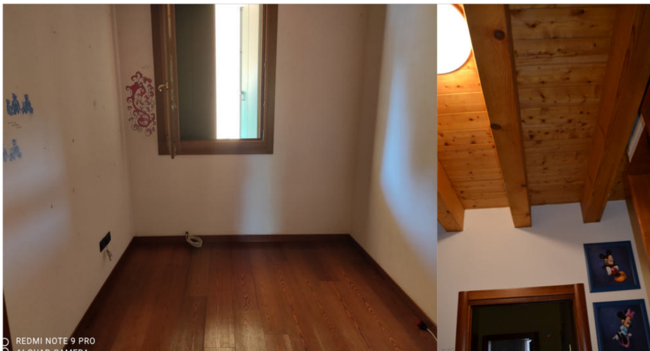
Figure 57-58- 1° PIANO- RIPOSTIGLIO- DETTAGLIO SOLAIO IN LEGNO CON TRAVI A VISTA;
