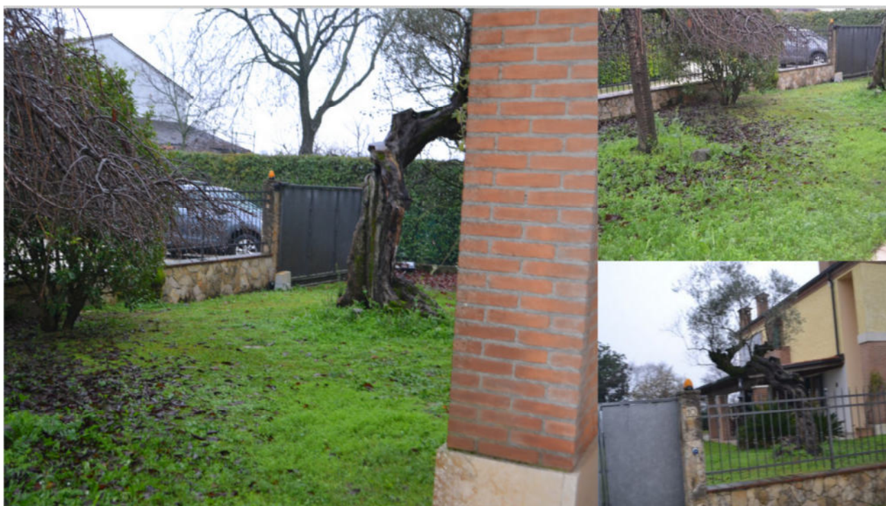
Fig.23-24-25- INGRESSO CARRAIO- APERTO ABUSIVAMENTE;
