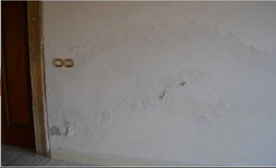
**Figura 58 - Androne problema umidità da risalita capillare- presenza sali.**
