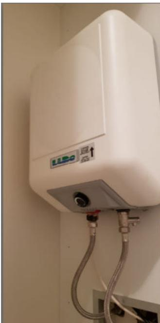
**Fig.54-Boiler per produzione acqua calda;**
