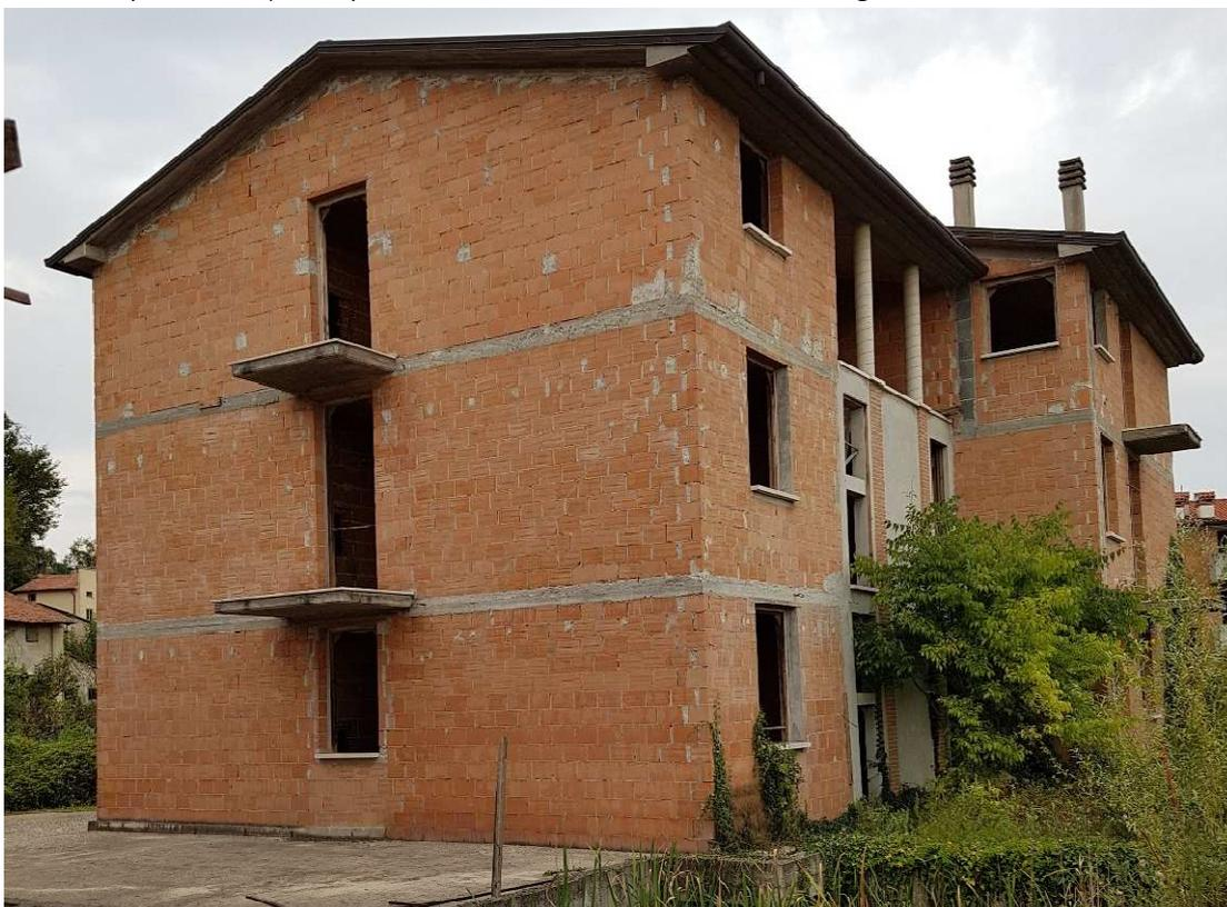
**Corpo D** risolto in un fabbricato di **due piani** fuori terra e uno interrato con **4 unità abitative** in fase di costruzione al grezzo (incidenza opere realizzate stimate al 45,0% delle opere finite) con presenza di cassamorta finestre, soglie in marmo
