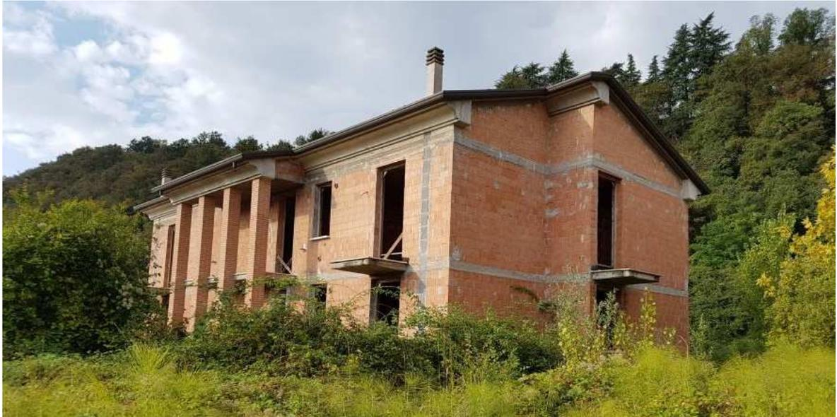
**Corpo B** risolto in un fabbricato di **due piani** fuori terra e uno interrato con **4 unità abitative** in fase di costruzione al grezzo (incidenza opere realizzate stimate al 45,0% delle opere finite), con presenza di cassamorta finestre, soglie in marmo
