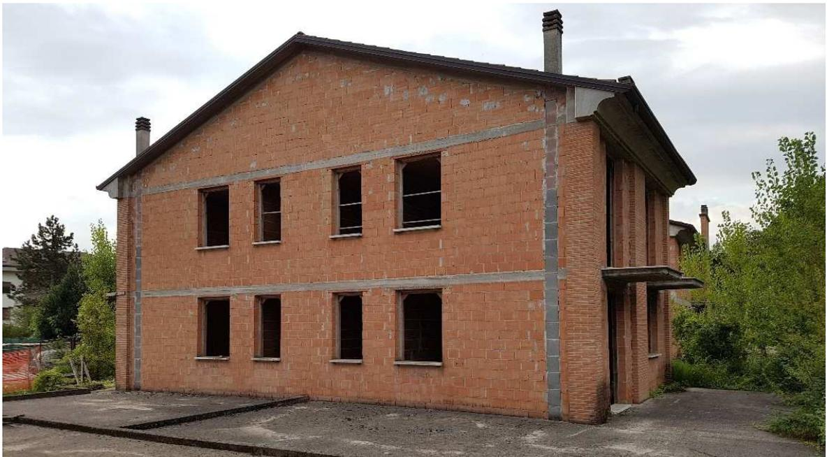
**Corpo C** risolto in un fabbricato di **tre piani** fuori terra e uno interrato con **9 unità abitative** in fase di costruzione al grezzo (incidenza opere realizzate stimate al 45,0% delle opere finite) con presenza di cassamorta finestre, soglie in marmo;
