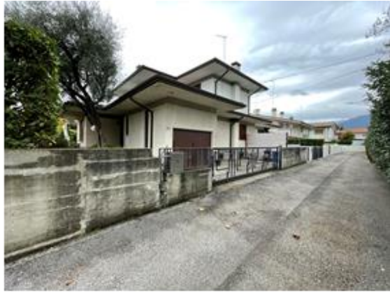
- Veduta generale esterna fabbricato
