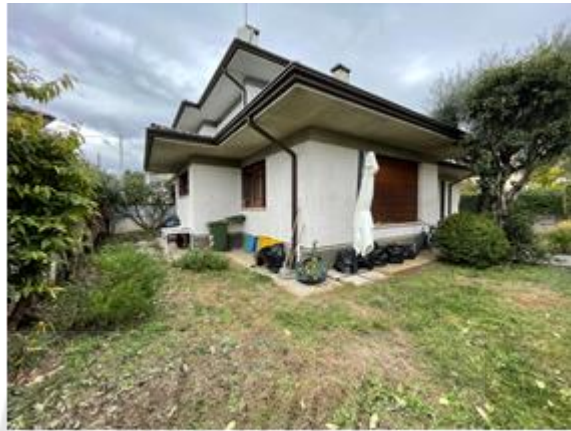
- Veduta generale fabbricato
