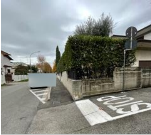
- Veduta generale esterna fabbricato
