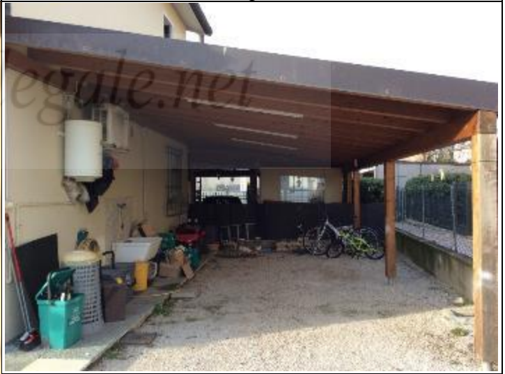
Foto 12: Tettoia sul retro
