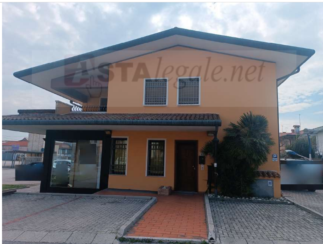
Foto n 1 – fabbricato condominiale
