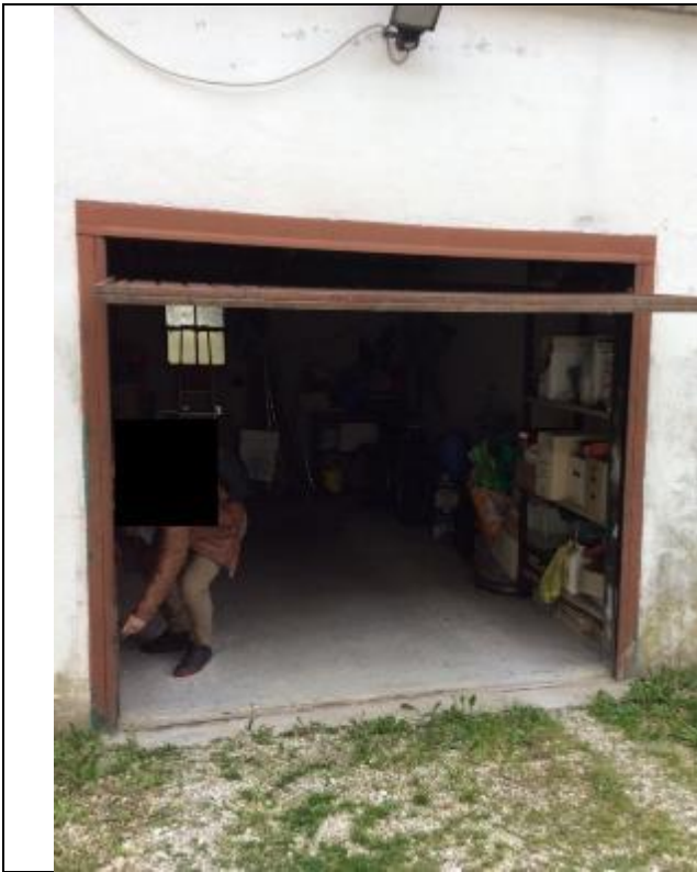
Foto 13: Garage di cui al m.n. 280 sub 5 - PT
