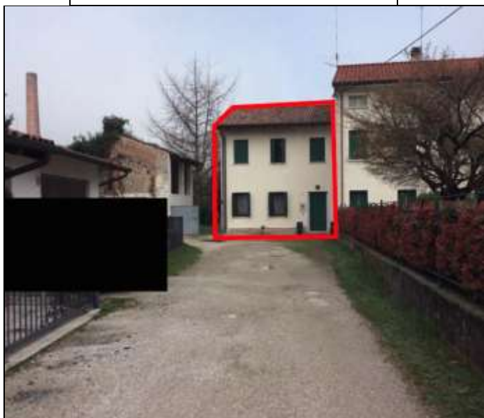
Foto 1: Esterni: fronte principale del fabbricato
