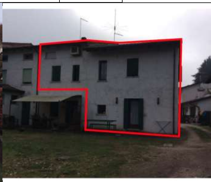
Foto 2: Esterni: fronte posteriore del fabbricato
