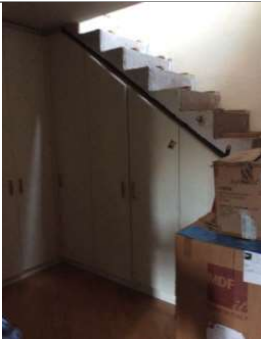
Foto 11: Disimpegno con scale di accesso al P2 (soffitta)
