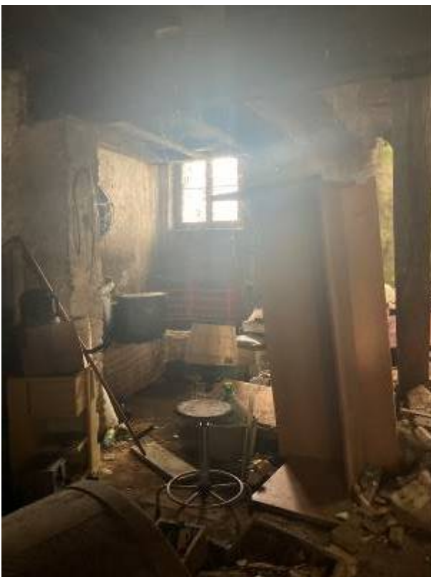
Foto piano terra (sotto): cantina
