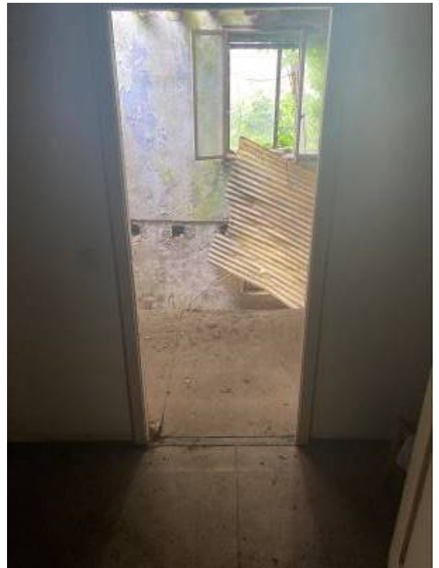
Foto interni piano primo: stanza con solaio crollato, ripostiglio, bagno
