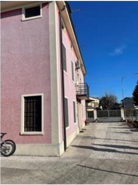
Foto n. 3 retro fabbricato lato ovest
