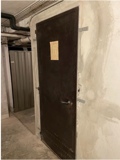
Foto 18. Corridoio comune piano interrato
