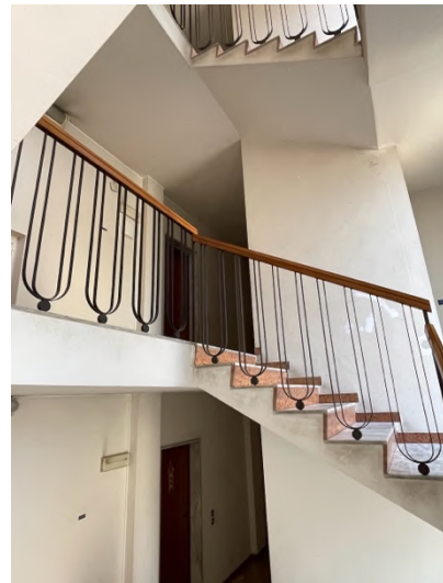
Foto 3. Vano scala comune
