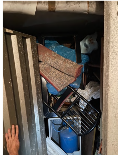
Foto 19. Cantina di pertinenza
