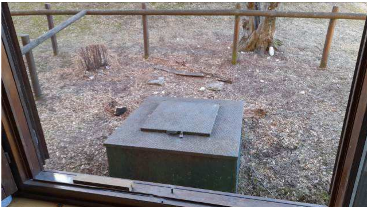
Figura 10. Cisterna condominiale per l'acqua.
