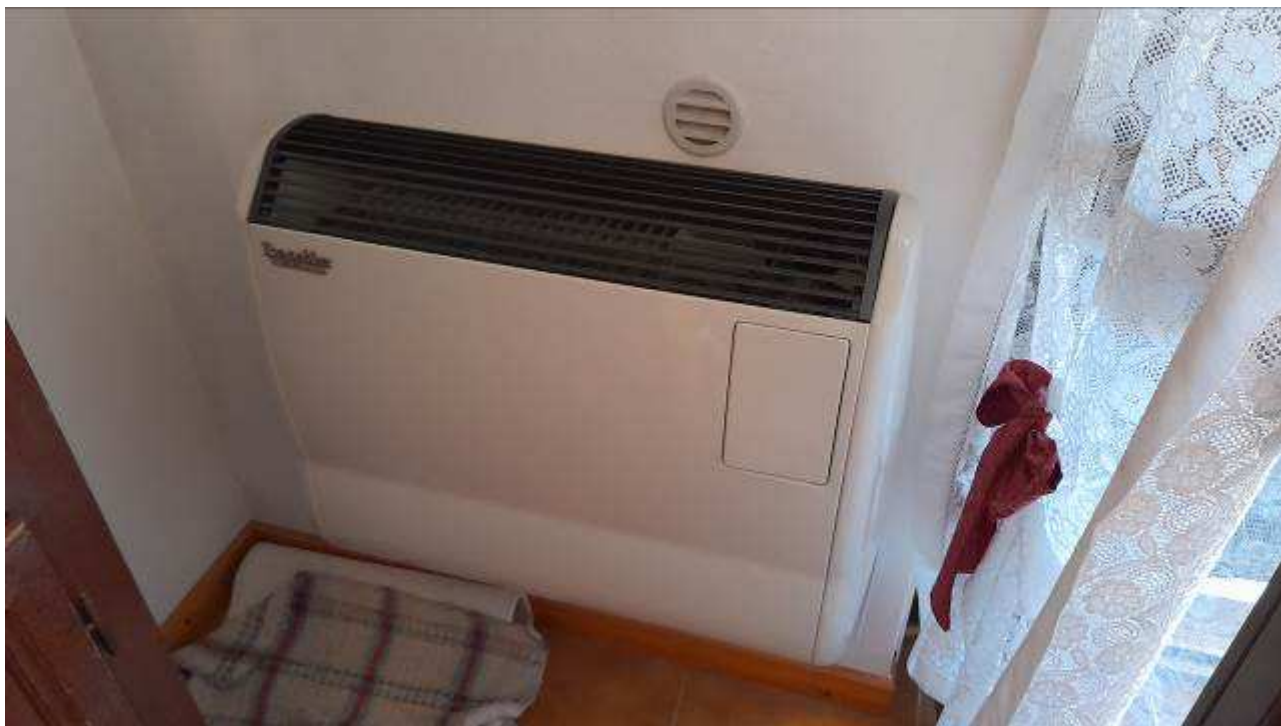
Figura 17. Generatore aria calda a gas.
