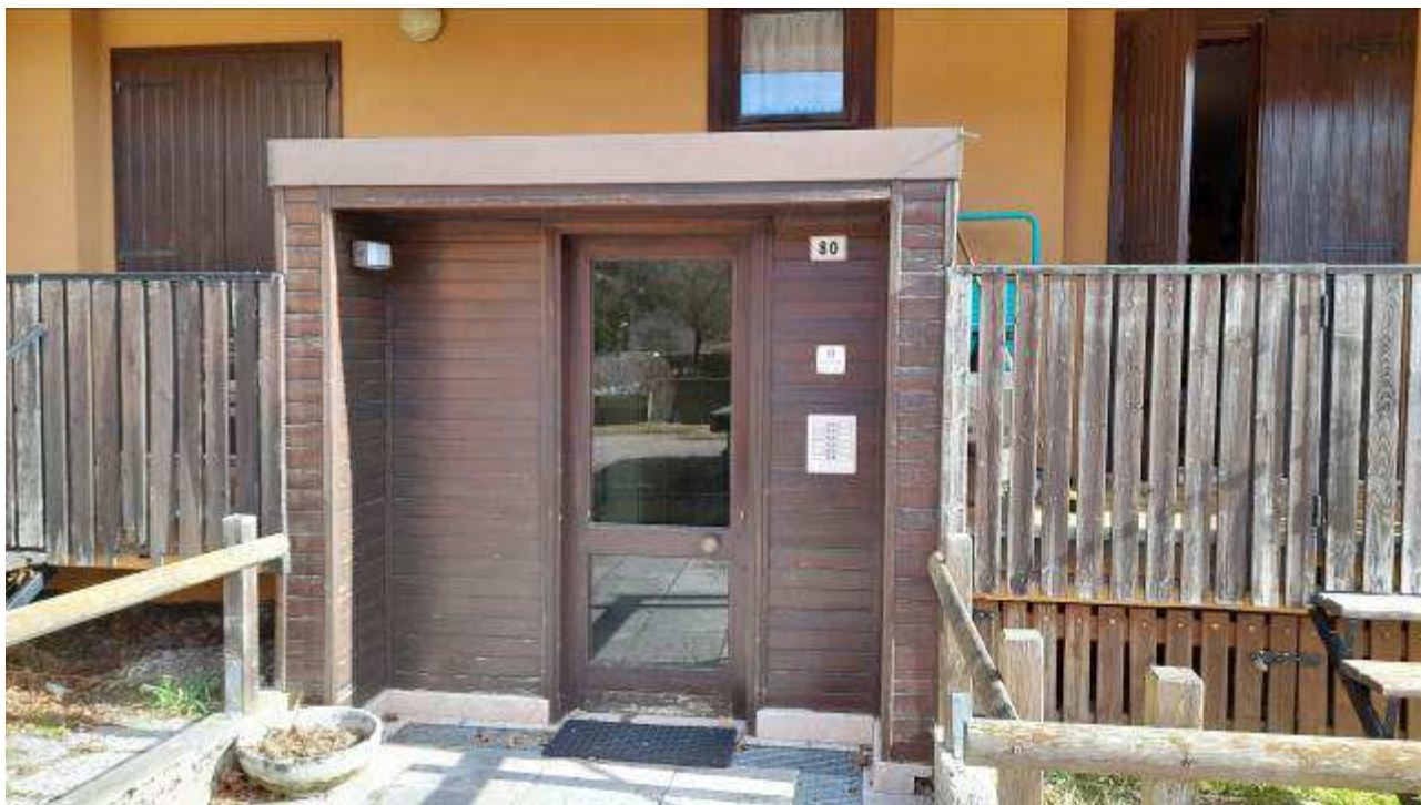
Figura 6. Ingresso vano scale comune.
