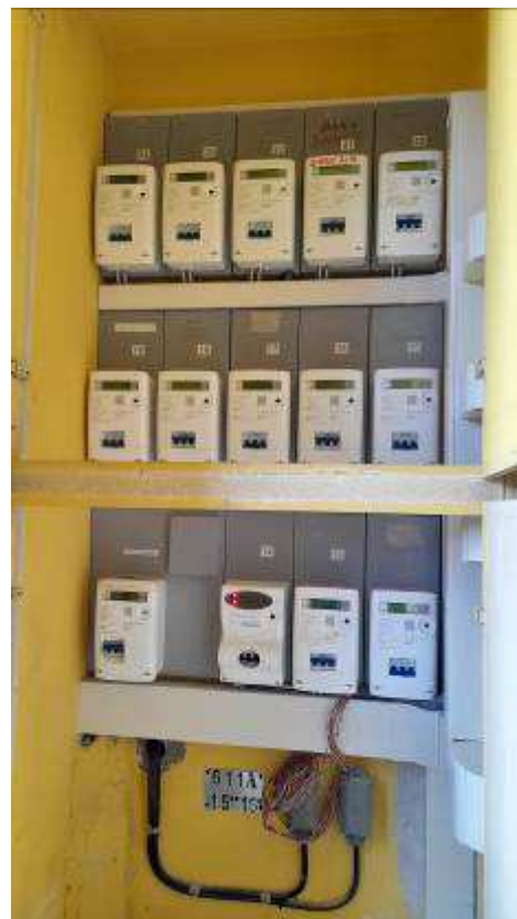
Figura 20. Quadri elettrici e contatori elettricit .
