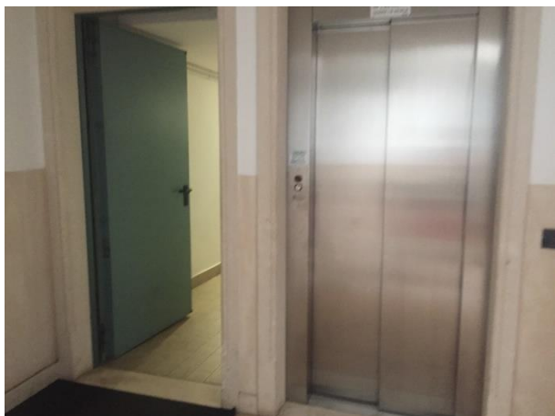
- Veduta accesso condominiale alle autorimesse
