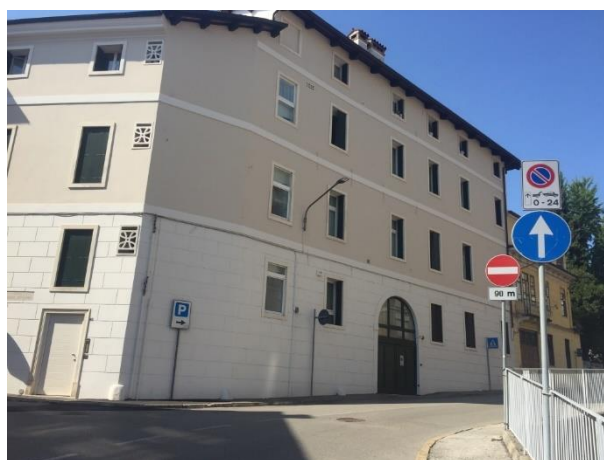
- Veduta esterno retro, verso nord, accesso carraiato
