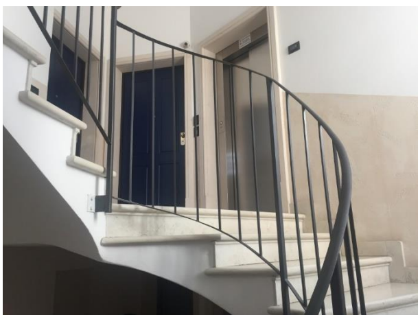
- Veduta scala condominiale interna
