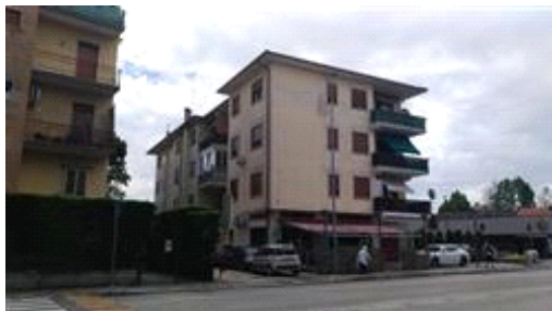
Vista generale da Nord-Ovest
