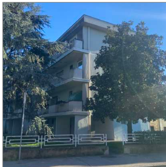
La palazzina fronte Est e Nord
