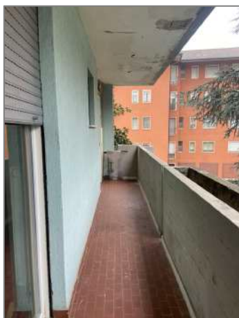
Terrazza lungo tutto il lato Ovest
