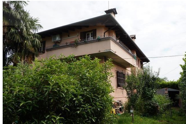
Angolo sud/ovest da corte interna
