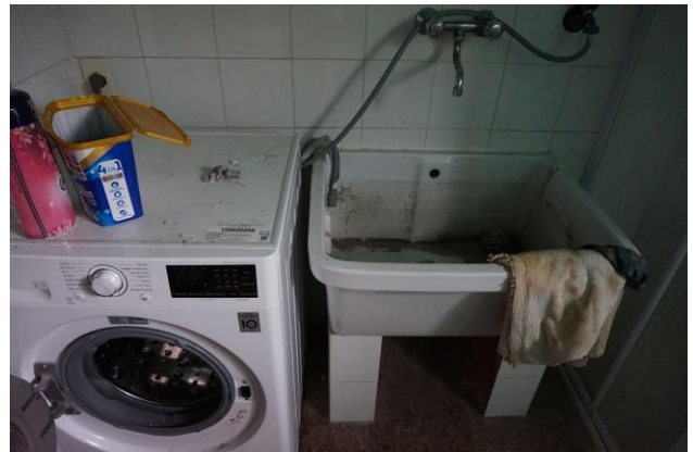
Piano seminterrato: bagno/lavanderia
