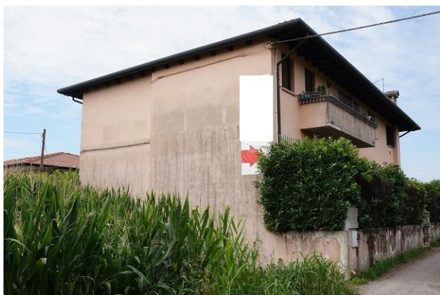
Vista da nord/est (da Via S. Marco)
