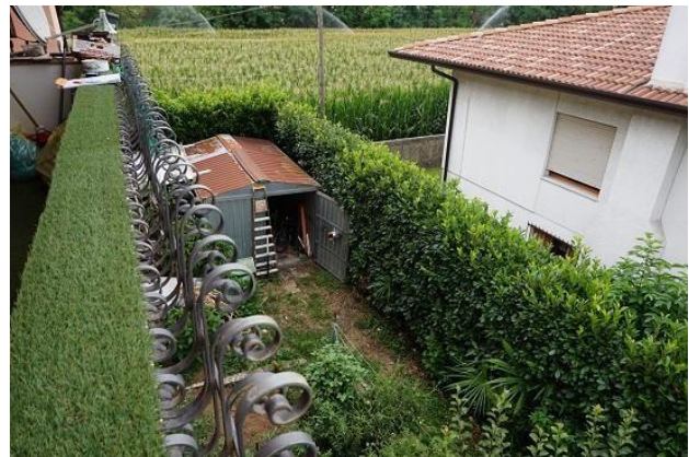
Manufatto in lamiera angolo sud/est da terrazzo p. primo
