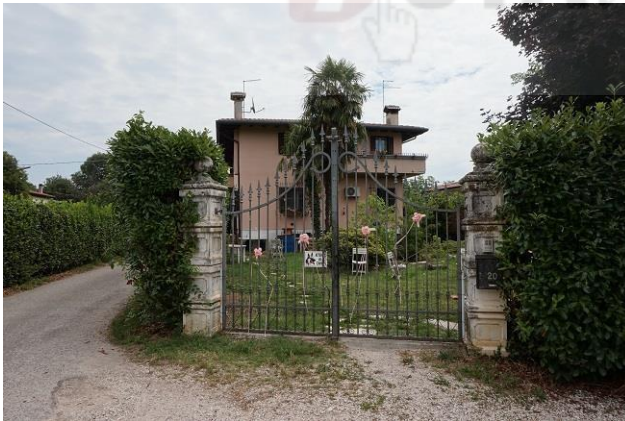
Ingresso carraio su angolo nord/ovest Particella n.378
