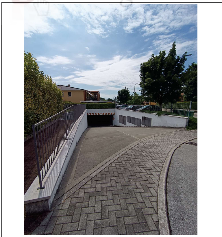
Foto n 1 – fabbricato condominiale
