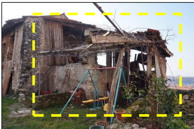
foto 18 - Deposito e tettoia vista dalla corte
