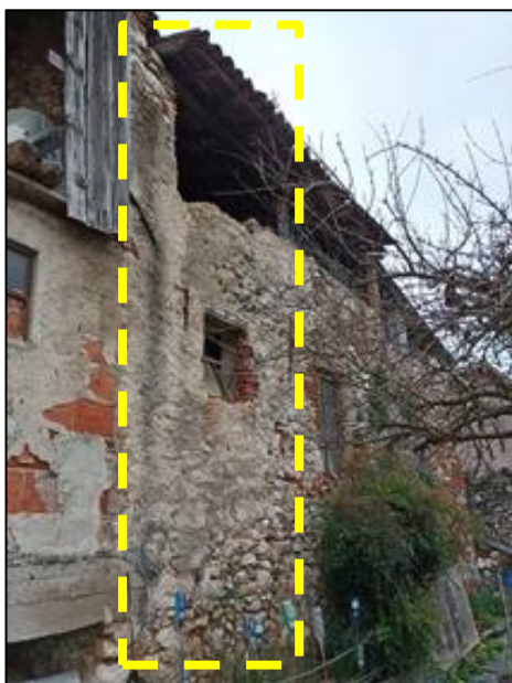
foto 16 - Prospetto verso valle
