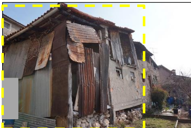
foto 19 - Deposito e tettoia vista dall'orto
