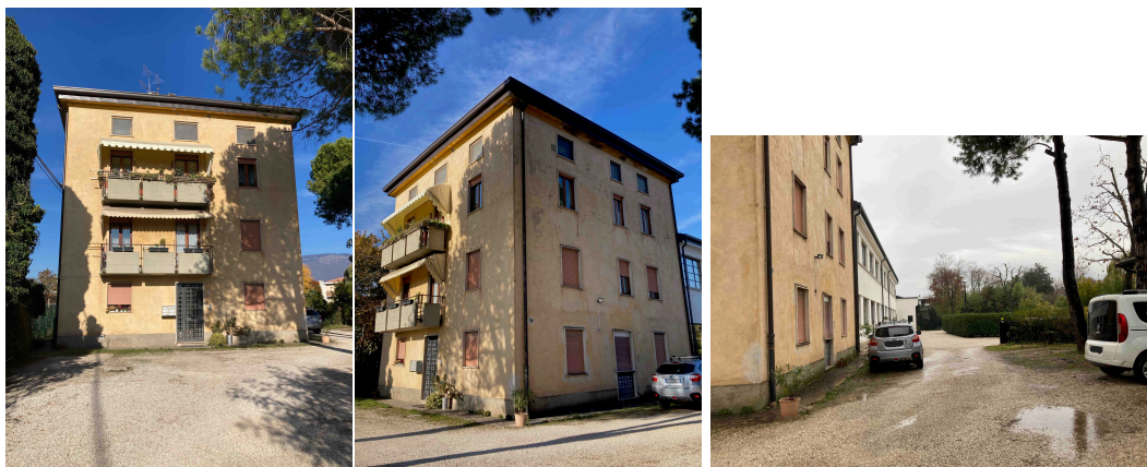
Viste dei fronti sud-est e nord-est del fabbricato condominiale e dell'accesso all'immobile artigianale adiacente
