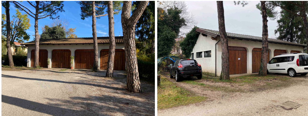
Viste del fabbricato adibito ad autorimesse
